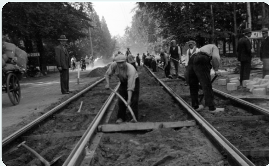
Foto: Verleggen van de trambaan Velperweg, ca 1933 door Jaarsveld's Wegenbouw Maatschappij, Silvolde ca 1933, Gelders Archief.
